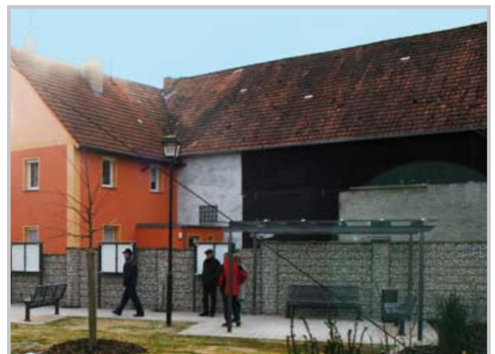
Stufenweise Sichtschutz aus Naturstein. Der schmale FERRONDO® - Steinzaun verbunden mit FERRONDO® - Rundsäulen
