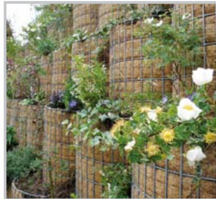
In Kürze wird diese Böschungssicherung (Hammerlitz am Attersee) mit verschiedenen Pflanzen bewachsen sein. (ob.)
