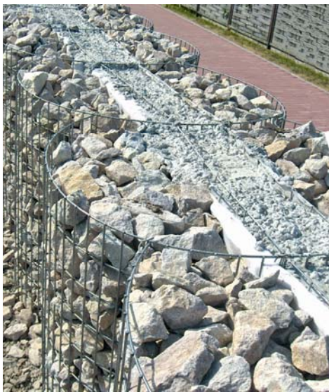
Bild 2: Hohe Schalldämmung durch das Dreikammersystem
